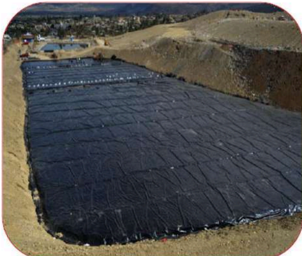
Figura 25. Colocación de la geomembrana impermeable. Relleno Sanitario de Zaachila, Oaxaca. Fuente: Sistemas de Ingeniería y Control Ambiental
